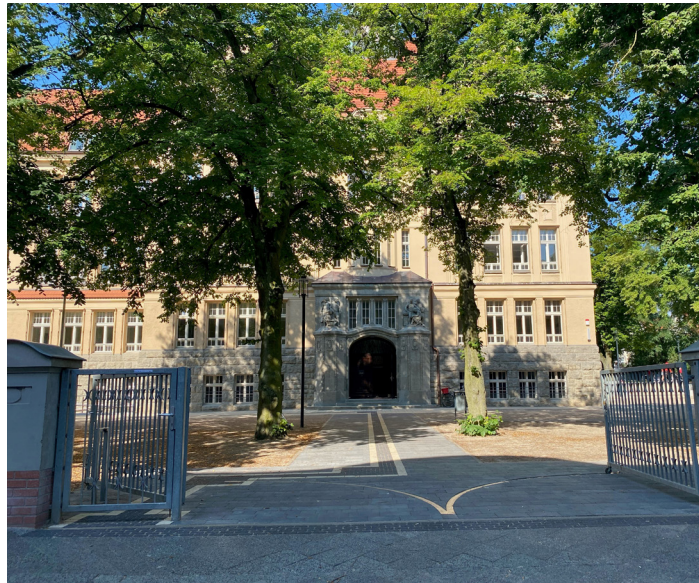
Nach knapp drei Jahren Bauzeit steht den 412 Schüler*innen der Klassen 5 bis 10 und 35 Lehrkräften der offenen Ganztagschule nun ein moderner, umgebauter und erweiterter Schulcampus zur Verfügung
