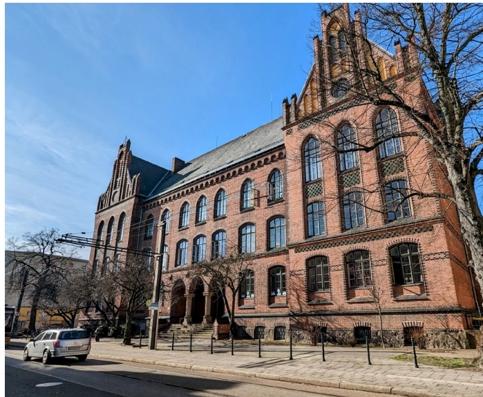
Im Sommer beginnt die grundhafte Sanierung der Friedenschule.
