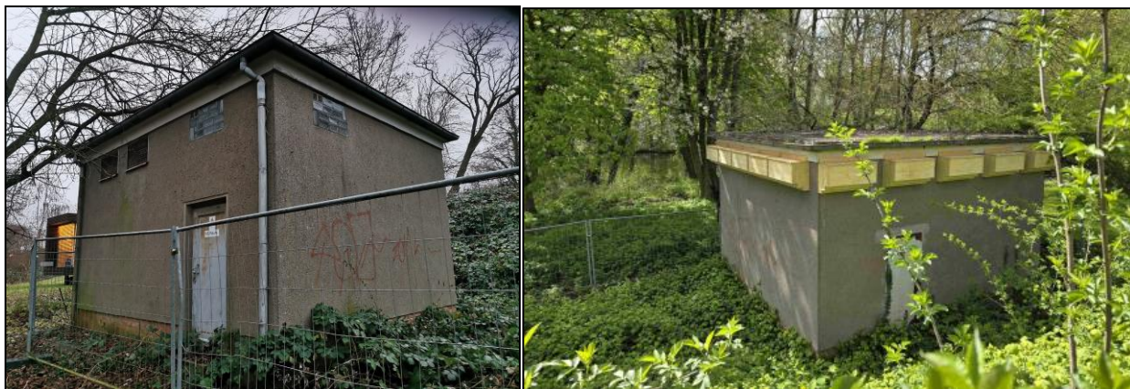
Abbildung 2: Trafohäuschen mit errichteten Übergangsquartieren.
