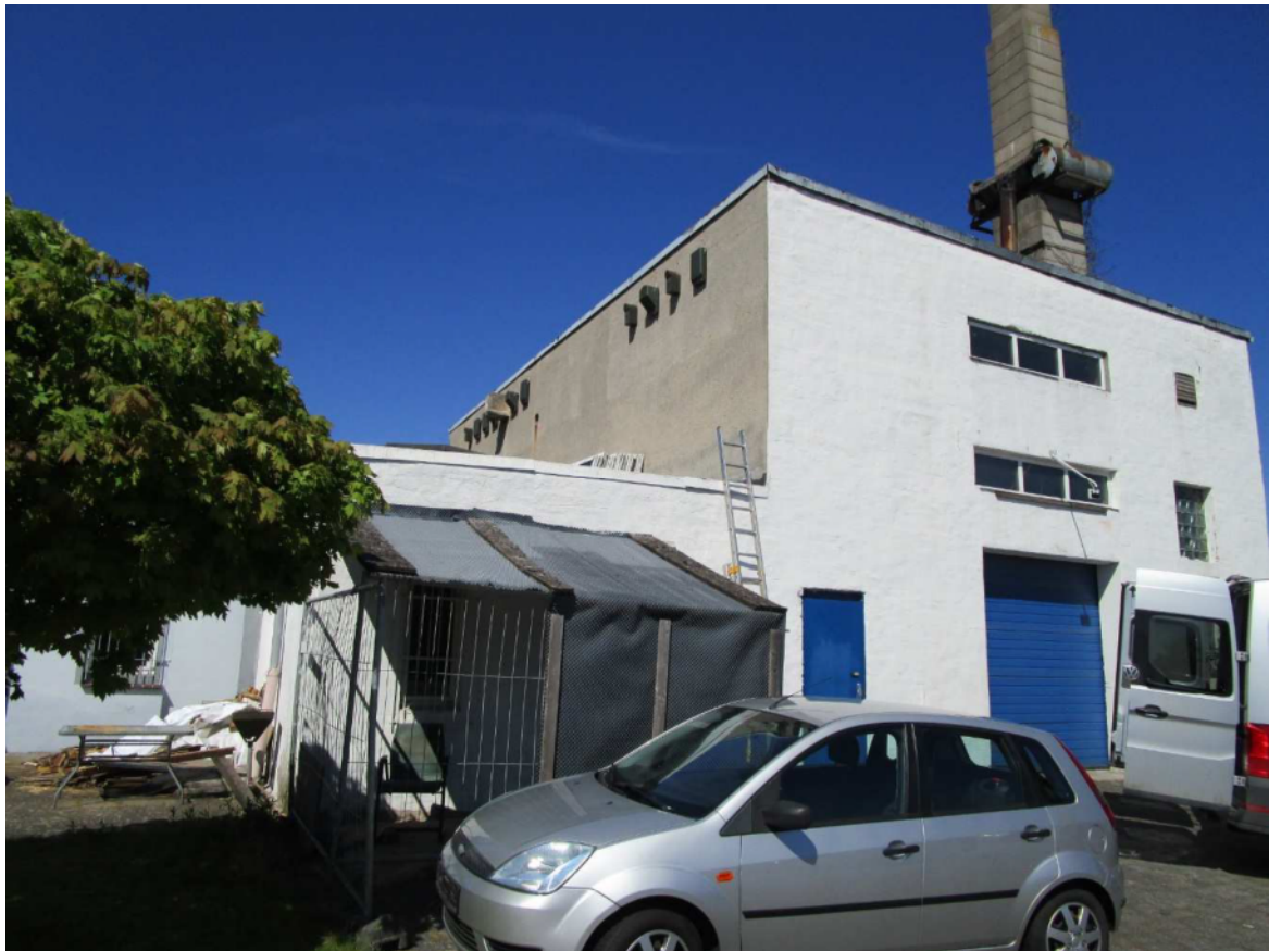
Abbildung 5: CEF1-Maßnahme an Nachbargebäude in der Möwenburgstr. 21 Anfang Mai 2023 (Foto CKS)
