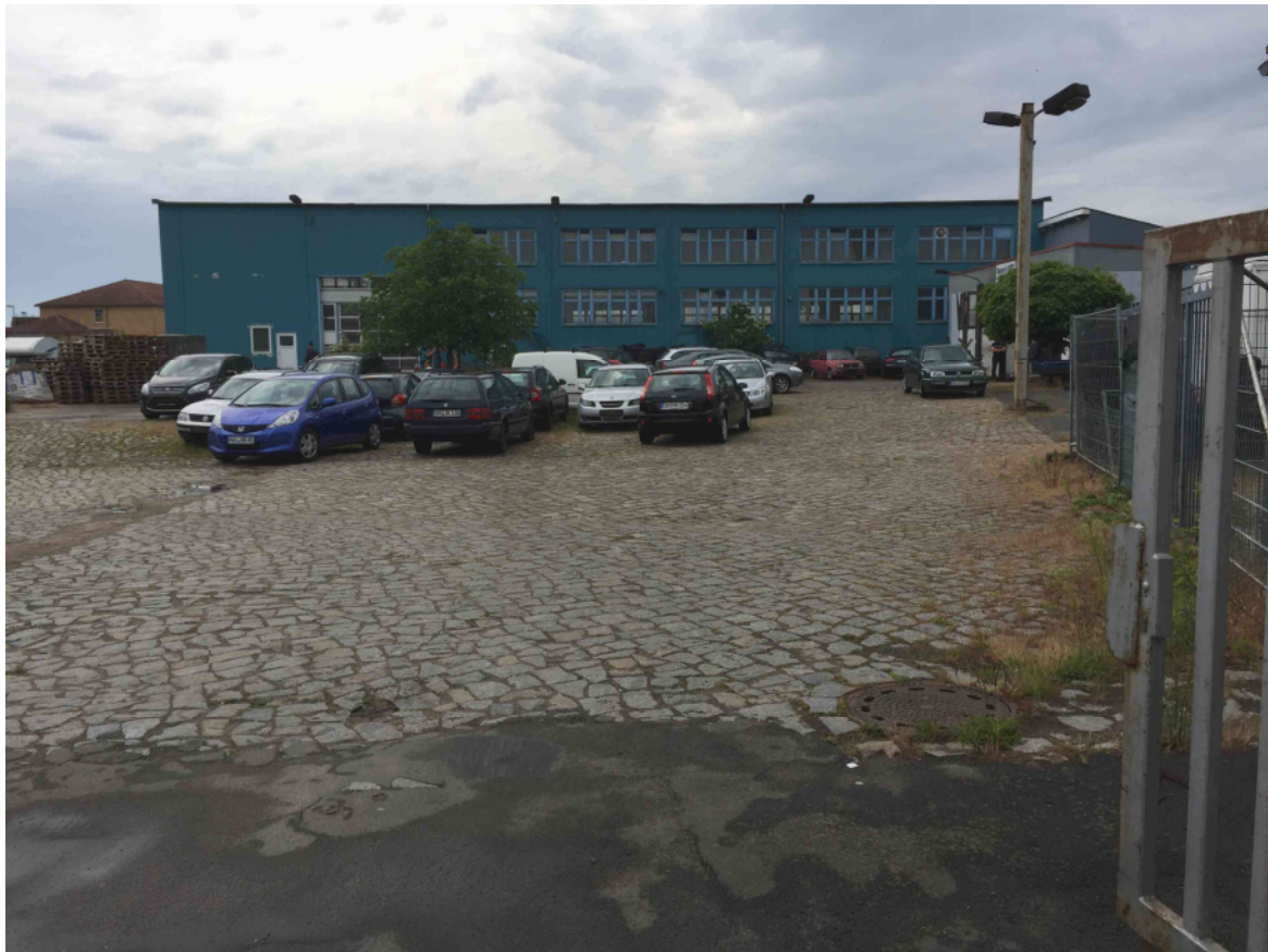
Abbildung 1: vorhandene große Halle mit befestigten Flächen
