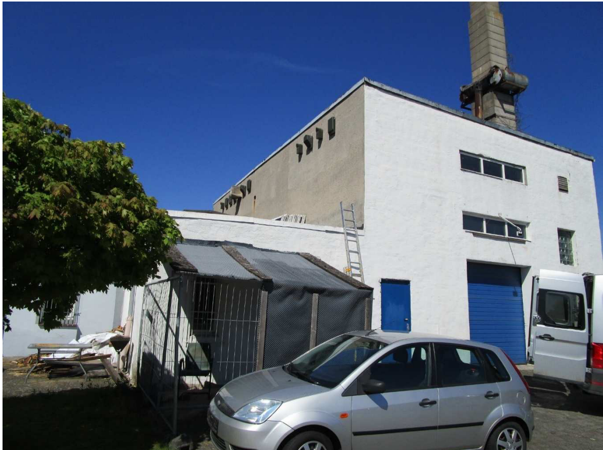
Abbildung 2: angrenzendes Gebäude mit Fledermauskästen
