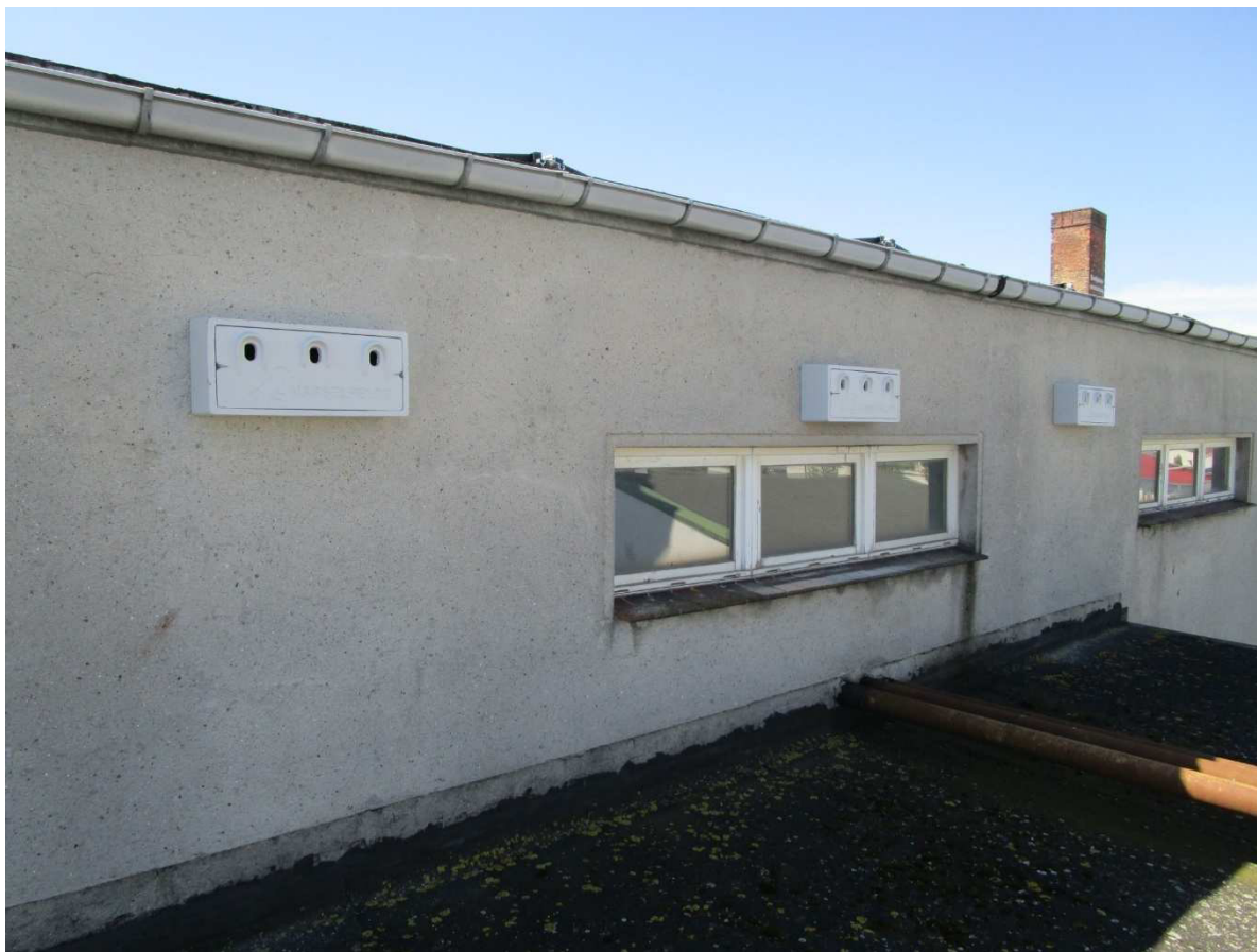
Abbildung 3: angrenzendes Gebäude mit Sperlingskästen
