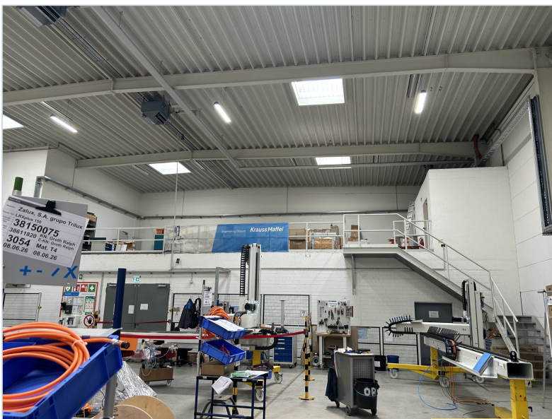
Hallenschiff mit Empore und Treppe
