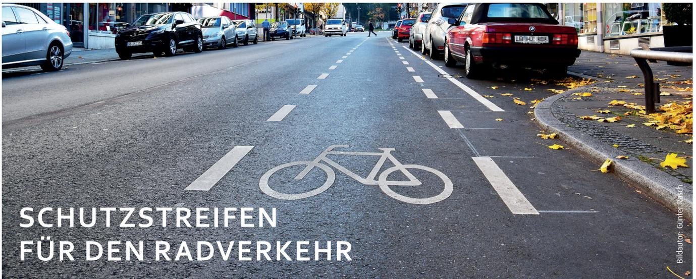
**Schutzstreifen machen den Radverkehr sichtbar:** Gestrichelte Linien und Fahrradpiktogramme auf der Fahrbahn zeigen allen Verkehrsteilnehmern: Hier sind auch Radfahrende unterwegs.
