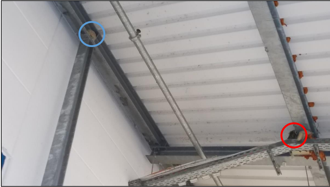
Abbildung 12: Nistplatz der Rauchschwalbe (blauer Kreis) und der Amsel (roter Kreis) an den Stahlträgern.
