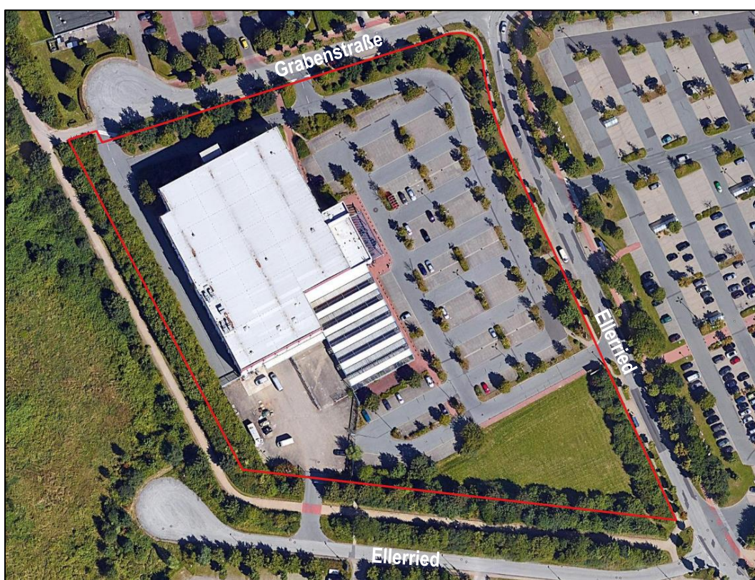
Abbildung 1: Satellitenbild des Vorhabengebiets, mit der in Rot eingezeichneten Grundstücksgrenze (Kartengrundlage: Google Earth).
