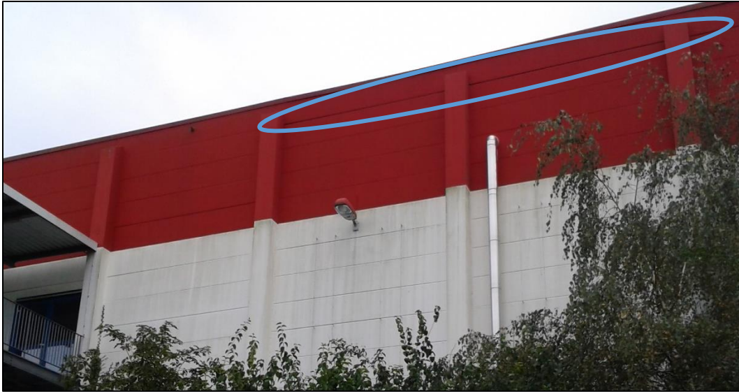
Abbildung 3: Beispielansicht der waagerechten Spalten in der Fassade (blau umrandet).
