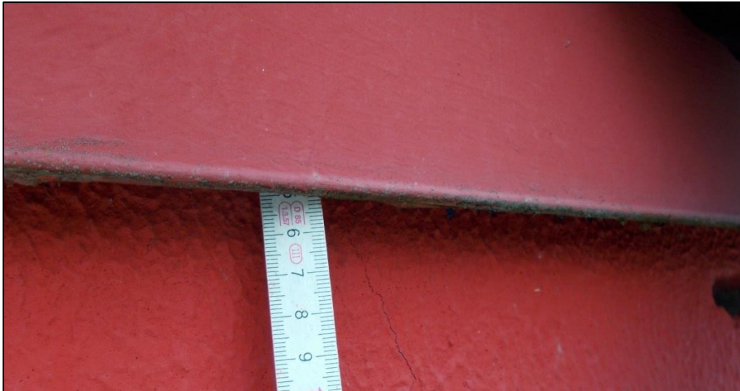
Abbildung 4: Nahansicht des fünf Zentimeter tiefen Spalts hinter der Blechabdeckung.
