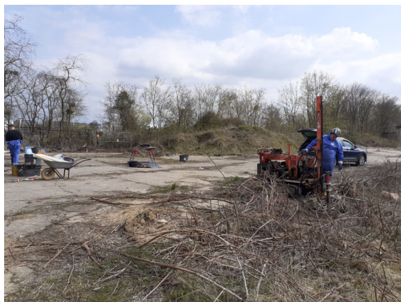
Foto 6: Bohrarbeiten im Osten
