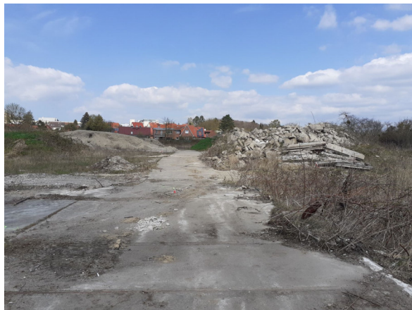
Foto 1: Zustand Fläche (Norden)
