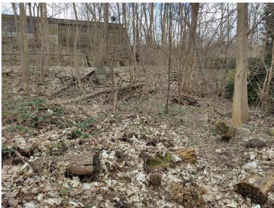
Bild 3 : Bestandsentwässer oberhalb des Ufers des Ziegelsees
