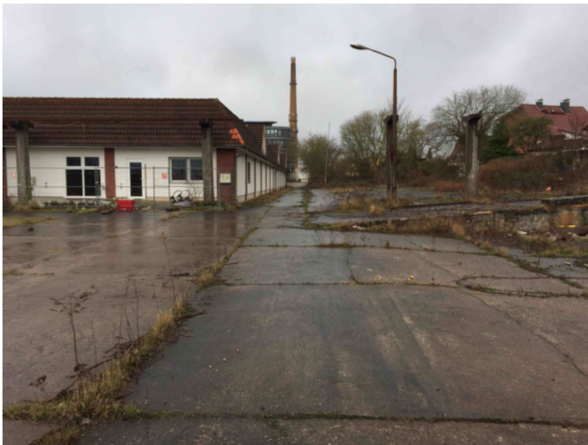
Abbildung 4: nördlicher Planbereich mit vorhandenem Gebäude
