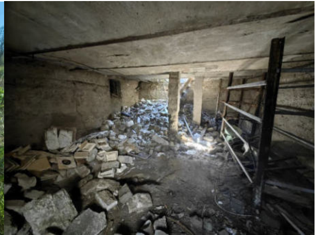
Abbildung 15: Über Betonschacht zugänglicher Keller, 15.04.2026.
