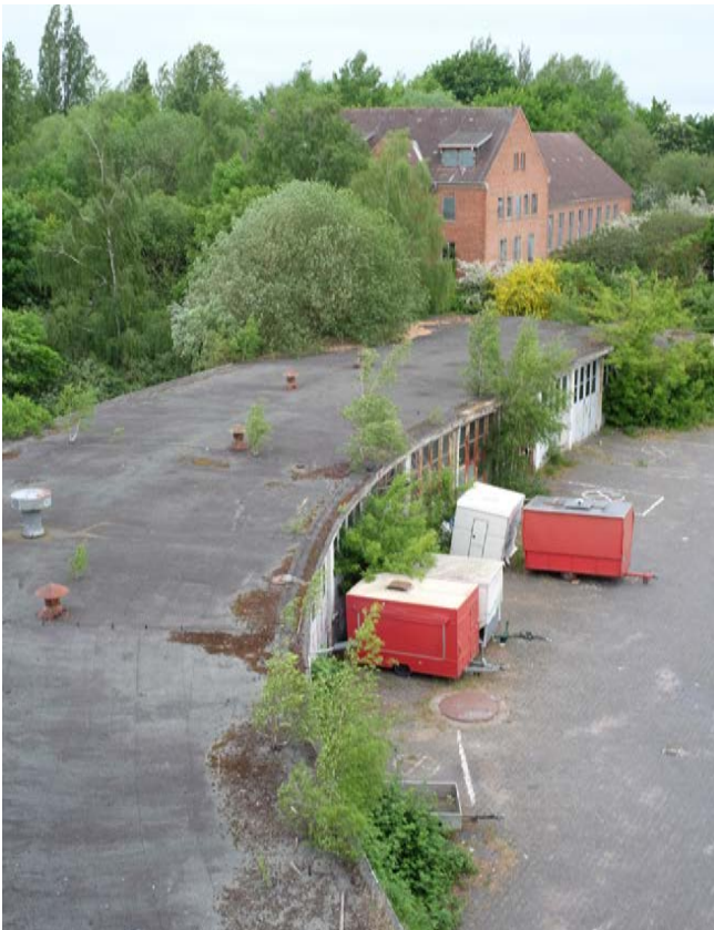
Garagenkomplex im heutigen Zustand © büro luchterhandt & partner
