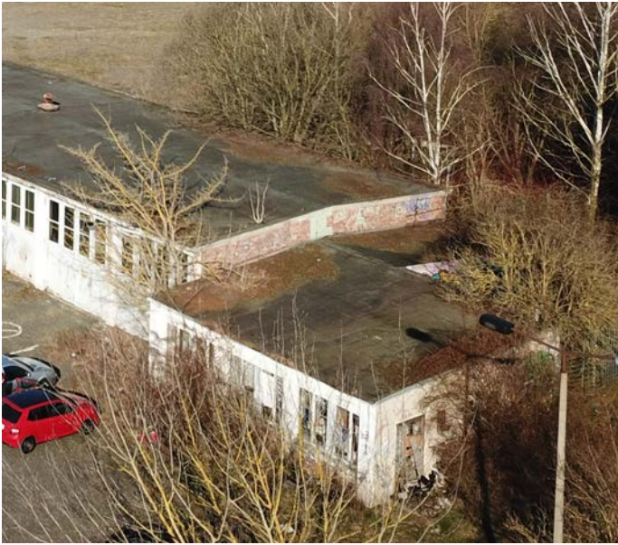
Der Anbau der Kundendienstzentrale © b2-medien
