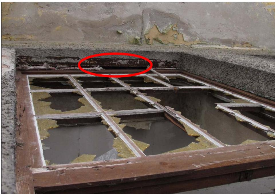
Abbildung 8 Durch das defekte Dehnungsband am oberen Fensterrahmen ergeben sich gute Einflugmöglichkeiten. Der darüberliegende Hohlraum ist u.a. für Wochenstubengesellschaft mehrerer Arten geeignet.
