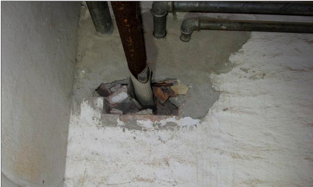
**Abb. 9:** Nicht vollständig vermauerter Wanddurchbruch im Ostflügel des Kellergeschosses. Die "Schadstelle" ermöglicht überwinternden Fledermäusen sehr tief in das zerklüftete Mauerwerk vorzudringen. Derart tief "sitzende" Tiere sind auch mit dem Endoskop kaum sichtbar zu machen.
