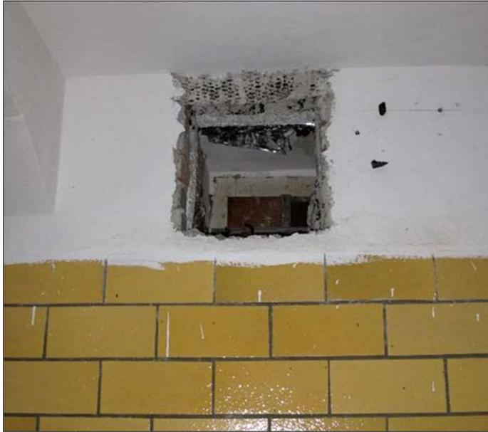
**Abb. 8:** Wanddurchbruch im hinteren Teil der Kühlkammer (Westflügel). Der Durchbruch führt durch Mauerwerk und Dämmung hindurch und ermöglicht überwinternden Tieren an dieser Stelle in den tiefreichenden Spalt zwischen Dämmung und Mauerwerk zu gelangen. Der Spalt kann eine seitliche Tiefe von mehreren Metern aufweisen und damit zumindest mittleren Gruppen Überwinterungsmöglichkeiten bieten.
