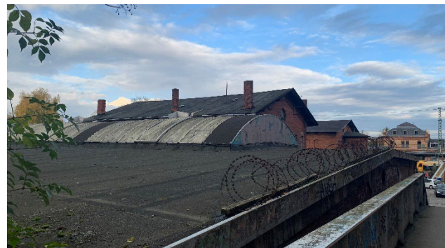
Abb. 26 Blick von Treppe auf Bahnhofscampus
