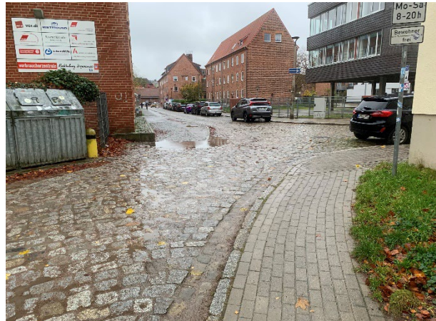
Abb. 32 Gehweg Dr.-Külz-Straße vom Bahnhof
