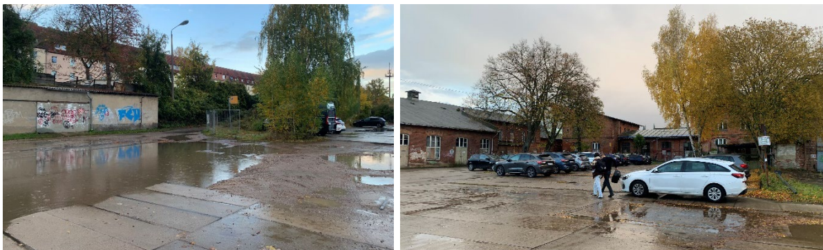
Abb. 13 Parkfläche auf dem ehemaligen Bahngelände (rechts) vor der Privatstraße (links)
