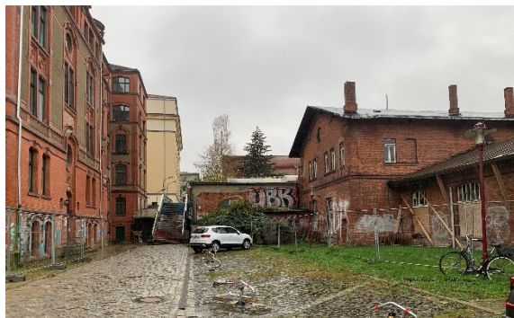
Abb. 25 Blick von Bahnhofsvorplatz auf Treppe, einer wichtigen Wegeverbindung
