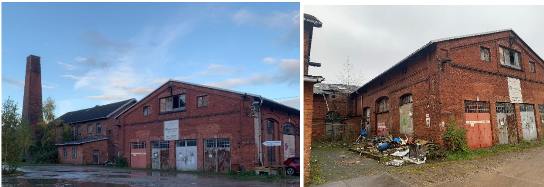
Abb. 22 Teil der denkmalgeschützten ehemaligen Werkstatt und Schornstein auf quadratischem Grundriss
