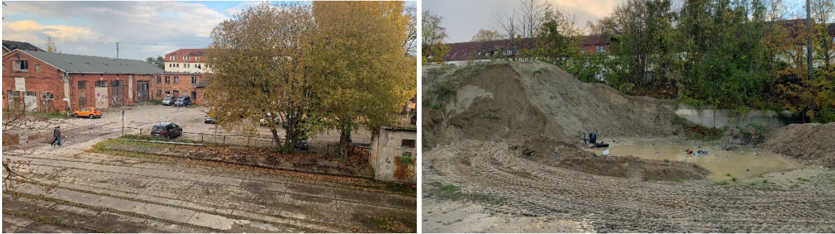
Abb. 8 Versiegelte Fläche (links) und Müll und Baumaterialeien (rechts) auf dem Bahnhofscampus
