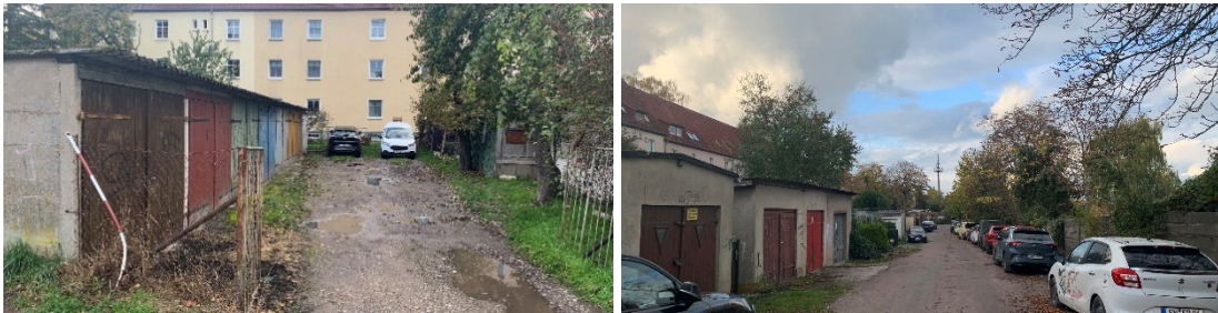
Abb. 29 Garagenbauten entlang der Dr.-Külz-Straße
