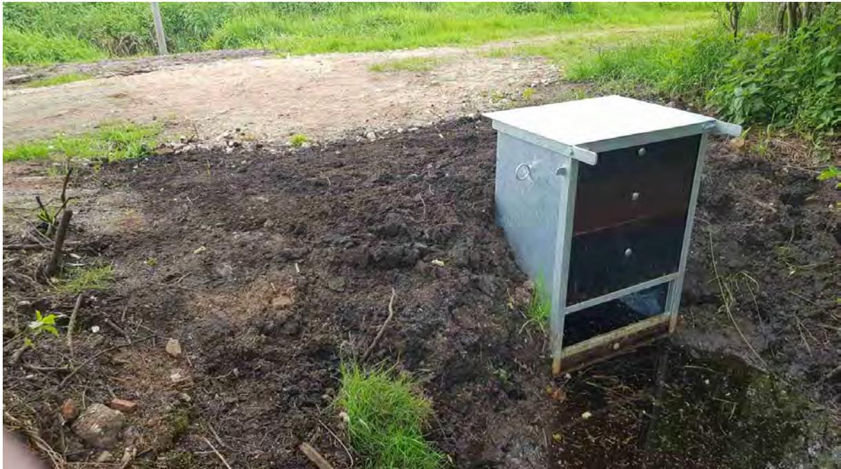
Abbildung 7: Mönch in Wegekörper eingebaut (Beispiel aus dem NSG Dosenmoor)
