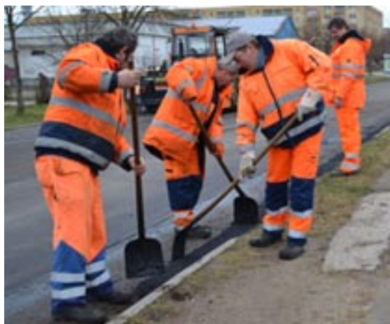
Mitarbeiter der SDS bei Asphaltierungsarbeiten in der Hamburger Allee. Foto: Landeshauptstadt
