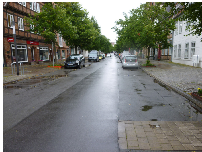
Ab 4. November wird die Straßenbaumaßnahme Großer Moor von der Einmündung der Landesrabbiner-Holdheim-Straße bis zur Einmündung in die Werderstraße fortgeführt. © Landeshauptstadt Schwerin
