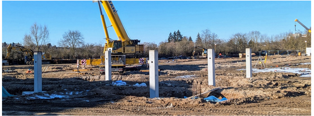
Die ersten Stützen für die neue Radsporthalle sind gesetzt.
