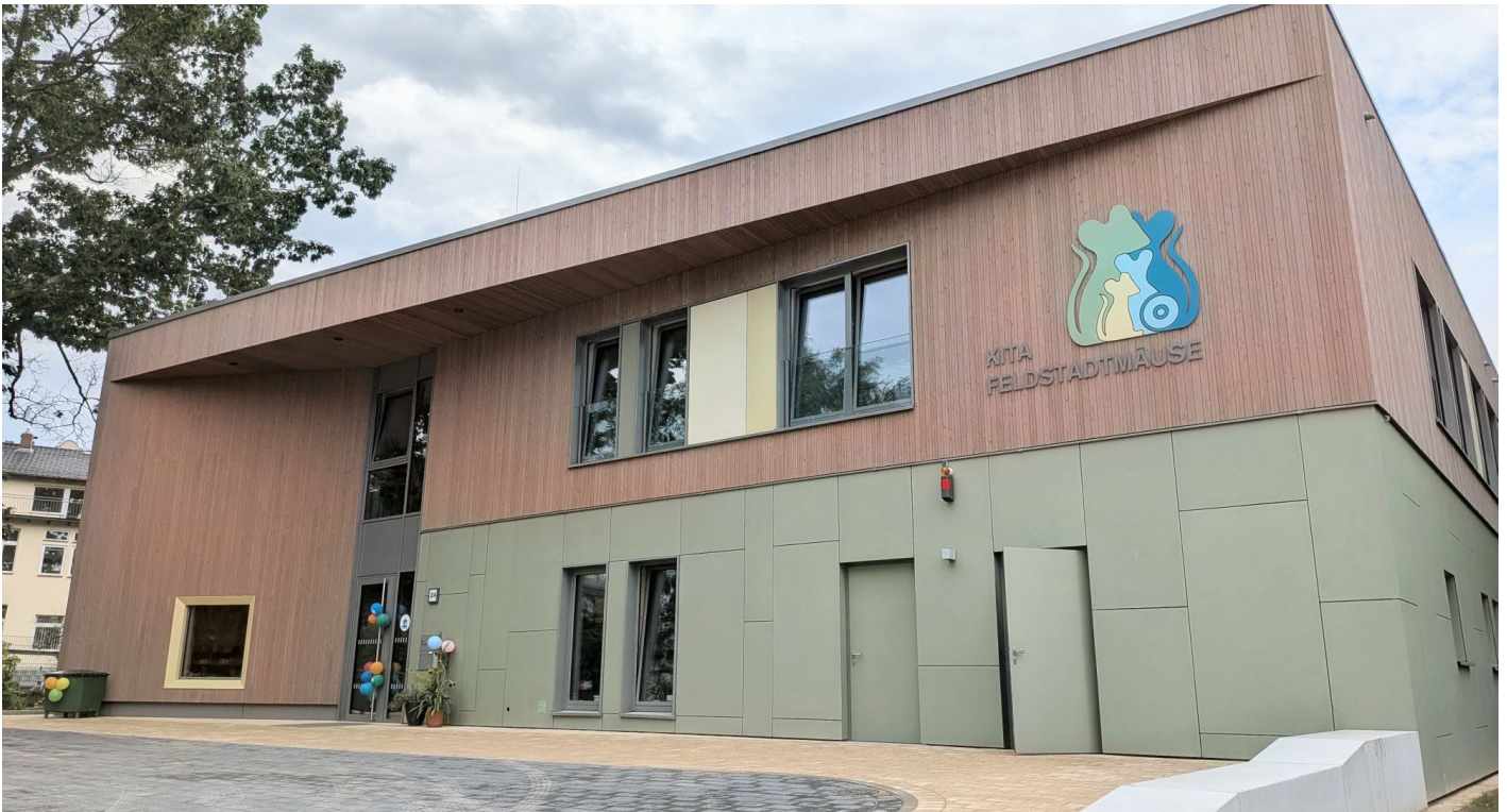
Rund 16 Monate nach der Grundsteinlegung wurde der Ersatzbau der Kita „Feldstadtmäuse“ fertiggestellt, der Platz für 105 Kinder bietet.
