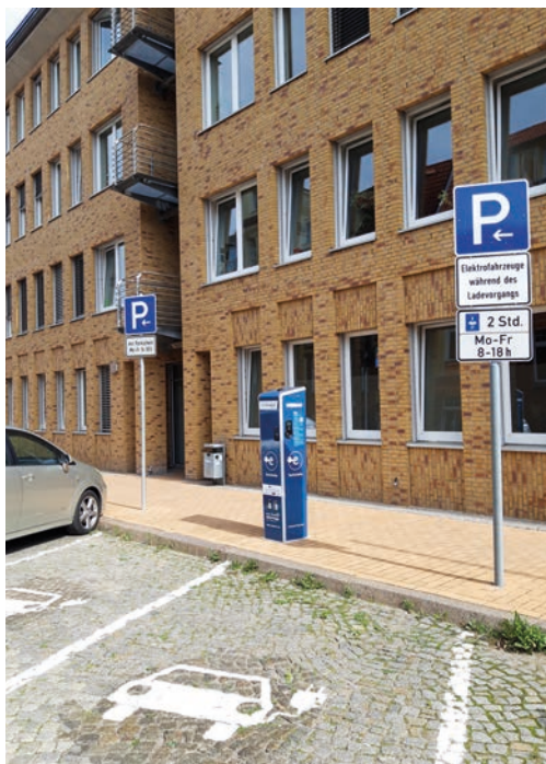
Ladesäule Elektro- mobilität (55)
