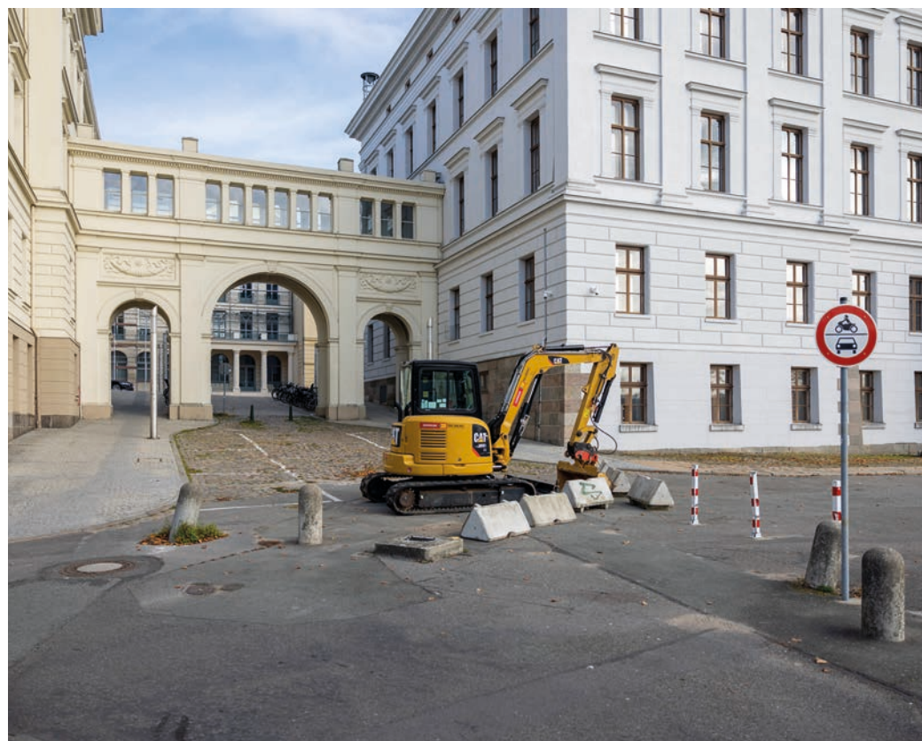
Bauliche Sicherheitsmaßnahmen am Kollegienübergang (42)
