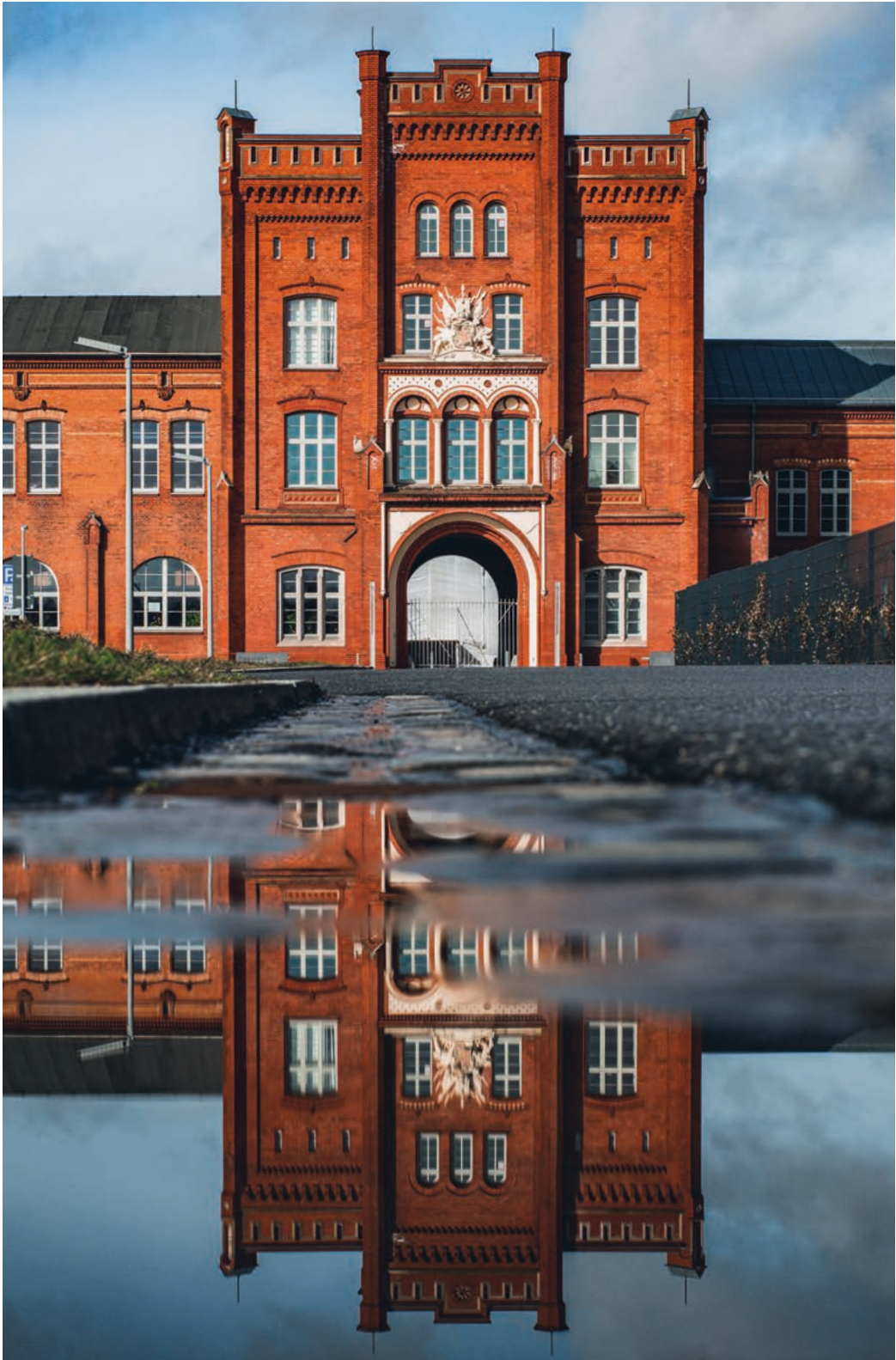
Eingang in die Alte Artilleriekaserne (35)
