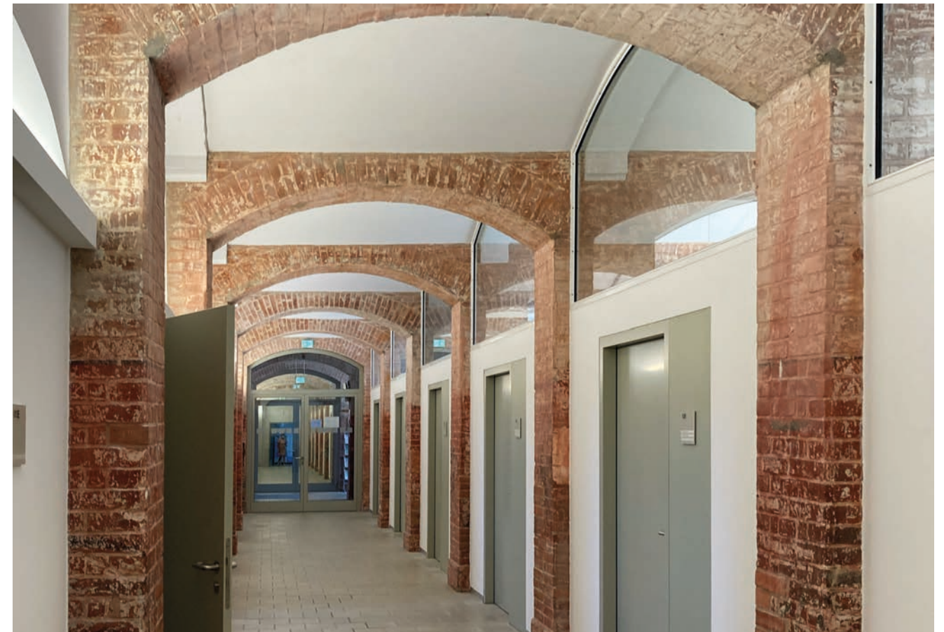
Moderne Büroräume in der ehemaligen Artilleriekaserne (41)
