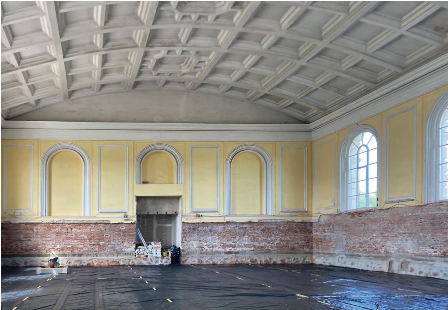
Marstall, Reithalle während der Sanierung (50)
