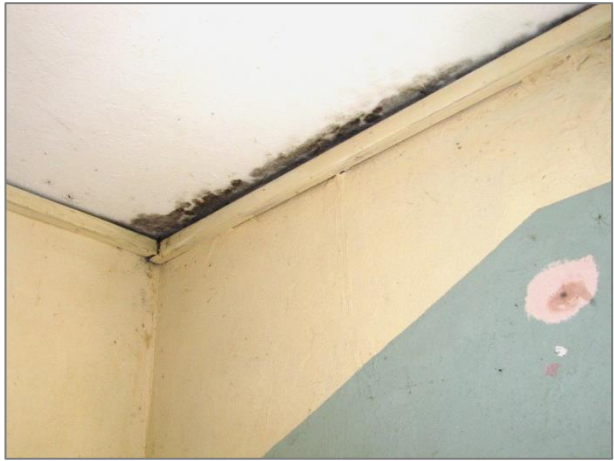
Deckenbereich Feuchtigkeitsschäden
