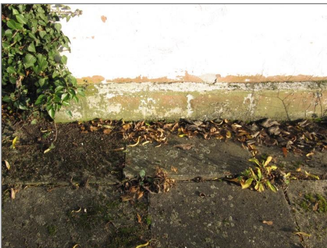
Feuchtigkeitsschäden
