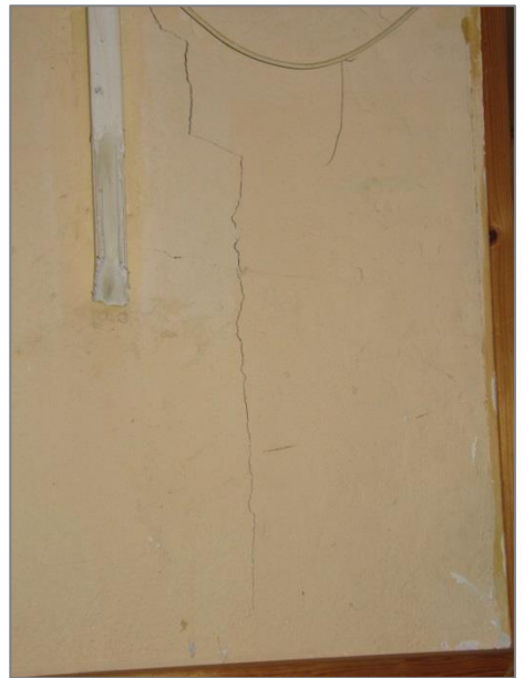
Unebenheiten, Risse Elektroleitungen auf Putz bzw. in Kabel- schächten
