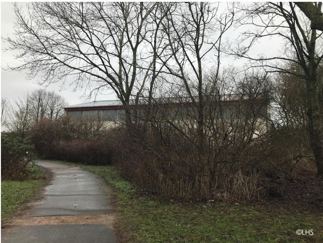
Vorhandene Turnhalle, Sanierung erforderlich (Stand: 20.01.2021)
